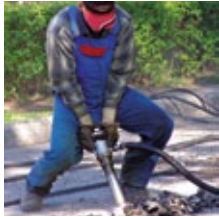
Bau und Montage
